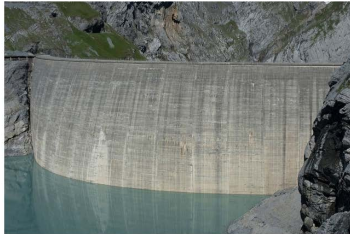
Grosswasserkraftwerke sollen Geld erhalten: Die Staumauer am Limmensee im Kanton Glarus. Bild: Archivbild/Keystone
